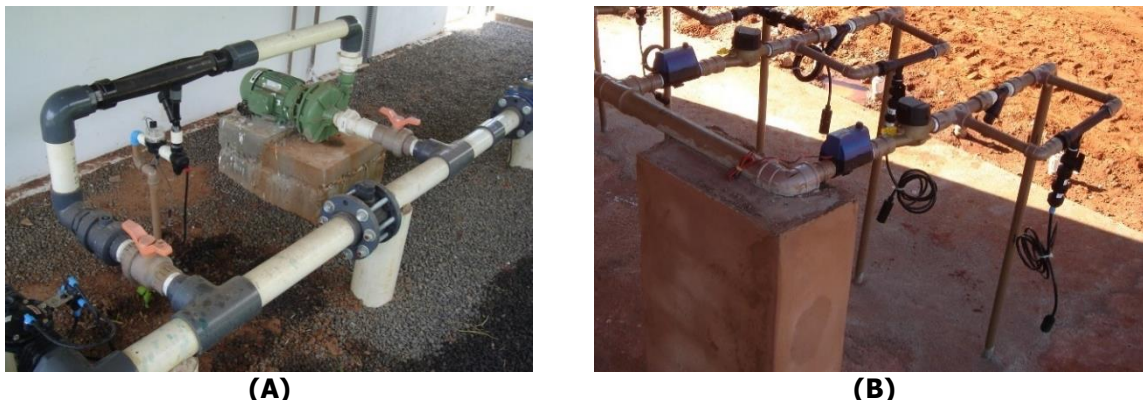
Figura 7. Sistema de fertirrigação utilizando injetor venturi (A) Bastos (2008), e (B) NaanDan Jain (2021).
