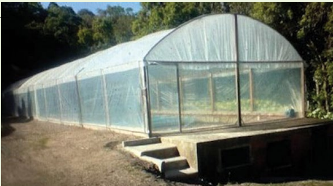
Figura 1 – Estrutura simples de estufa fechada de plástico, para cultivo protegido de hortaliças e outras culturas
