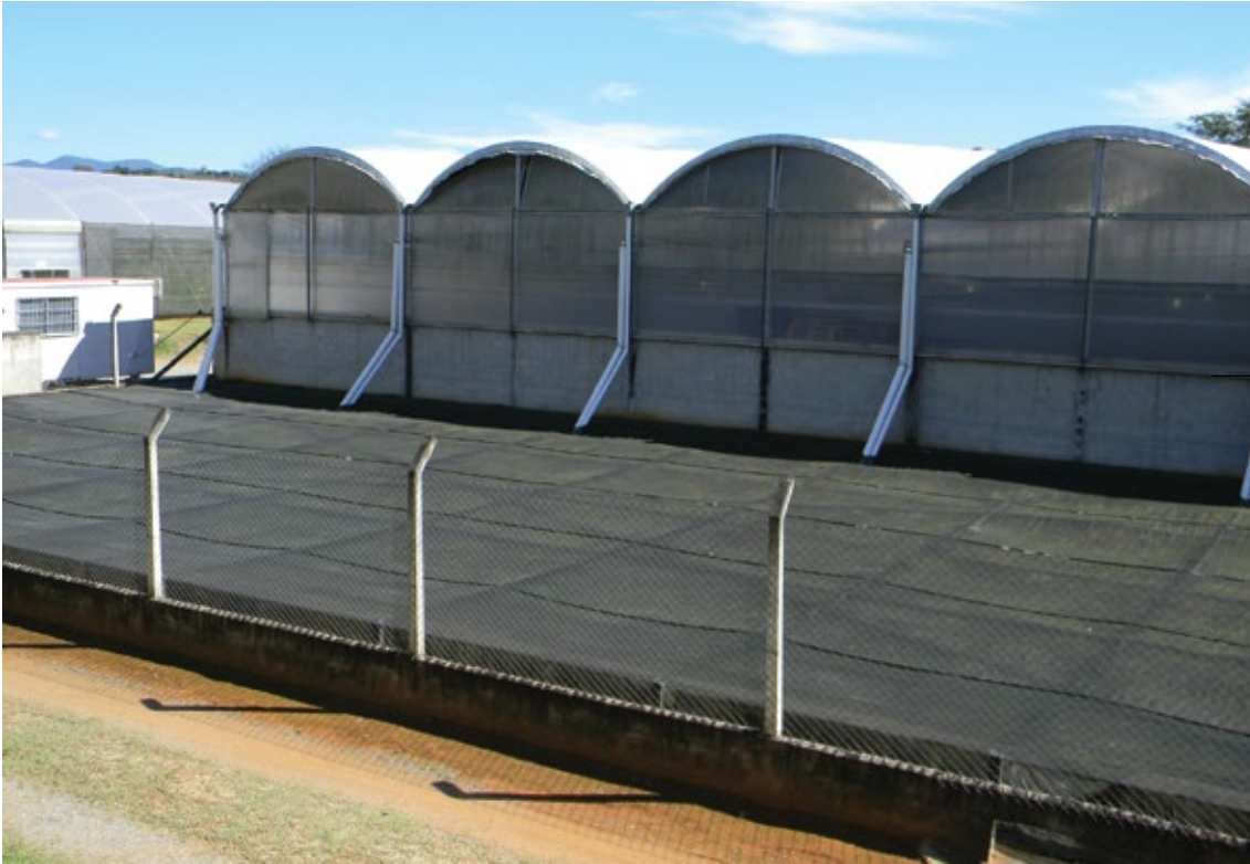
Estrutura de cultivos protegidos com sistema de coleta e armazenamento de água das chuvas
