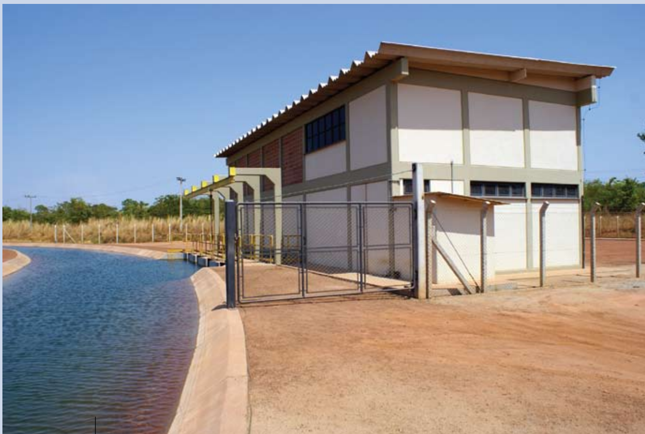
Estação de bombeamento do Projeto Público de Irrigação Manuel Alves, TO
