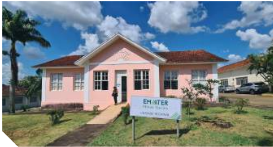
Figura 6 – Prédio do antigo DER, no campus histórico da UFLA
