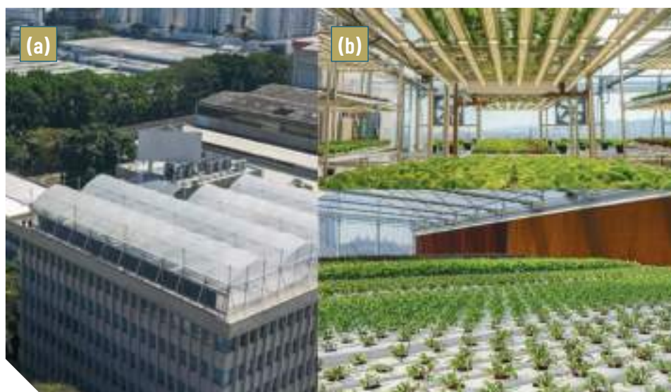
Figura 9 – (a) Estufa instalada sobre edifício urbano; e (b) cultivo vertical e horizontal de hortaliças em ambiente controlado, com uso de LEDs e sistemas hidropônicos
